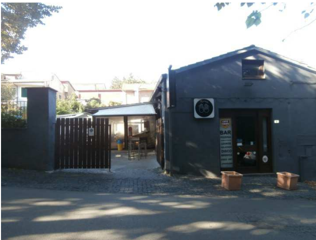
Ft.24 Entrata dal civico n.11: dal cancello si accede alla parte esterna del locale e all'abitazione
