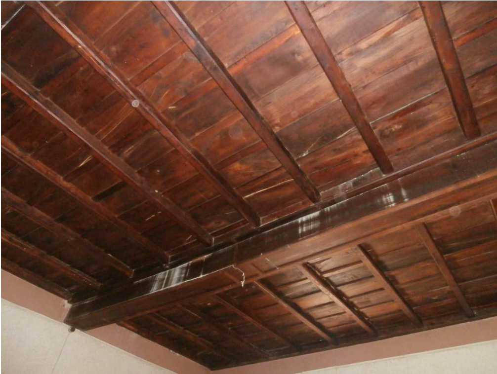
Ft.38 particolare del soffitto
