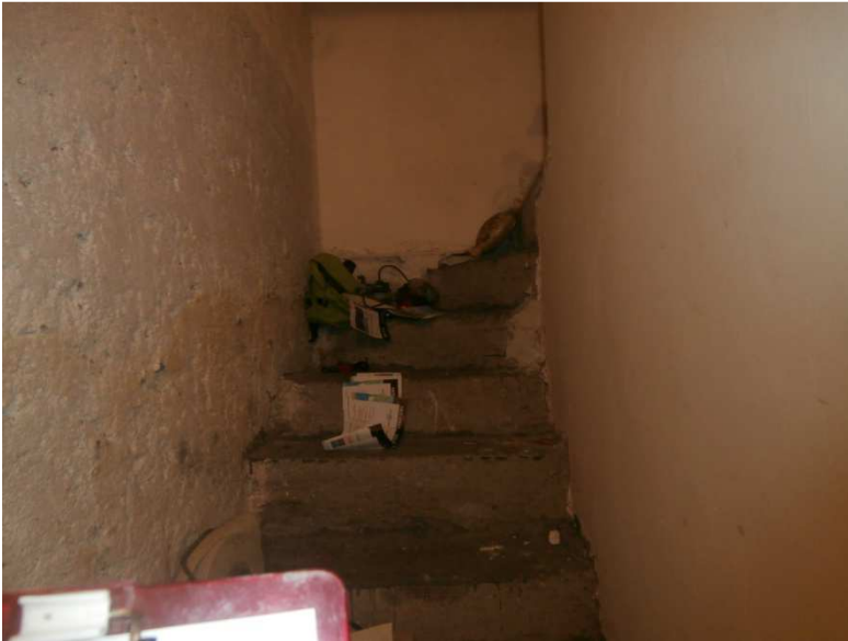
Ft.16 scala di accesso al sottotetto della zona cucina
