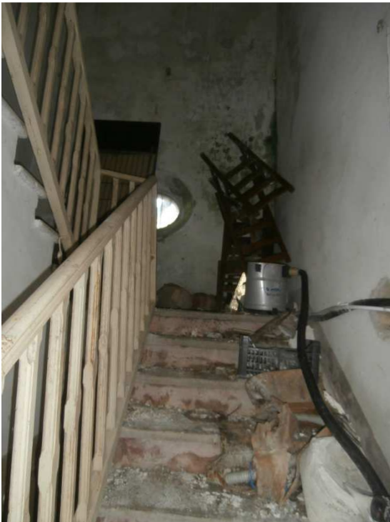
Ft.32 scala di accesso all'abitazione
